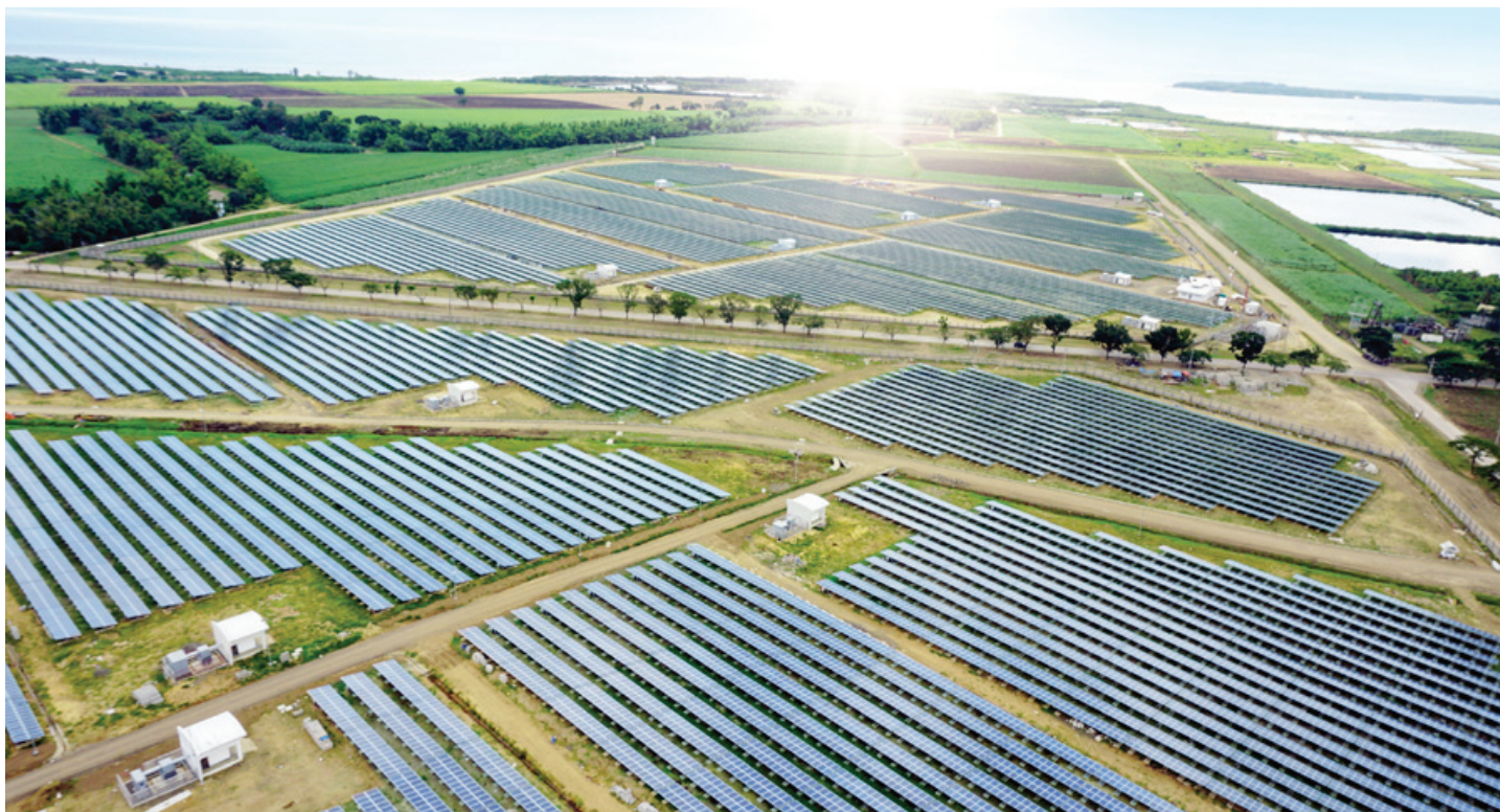
Das operative SaCaSol I & B in einer Luftaufnahme von Dezember 2014
